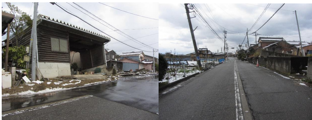
写真-1 県道8号線沿いの電柱や家屋
