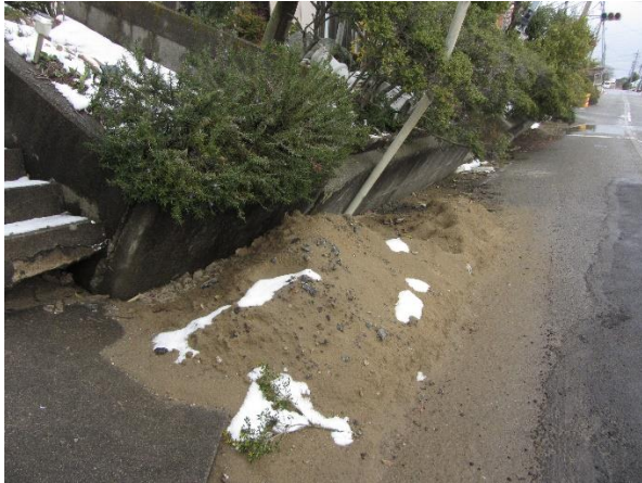
写真-3 傾いた擁壁と沈下したガレージ
