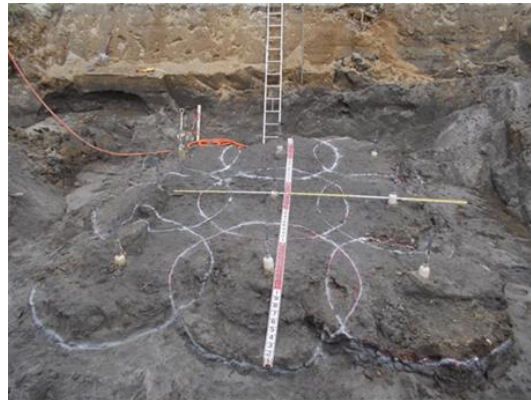
写真-7 改良体の発掘全景（唐津実証試験）
