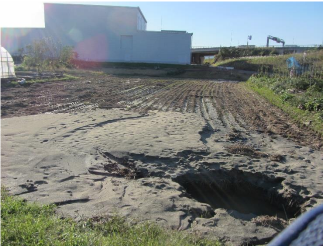
写真-1 基盤漏水による噴砂
