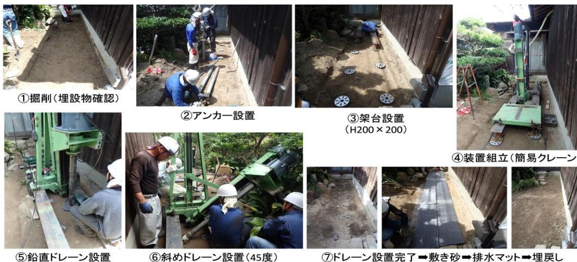
図1 ドレイン敷設の作業手順と施工状況
