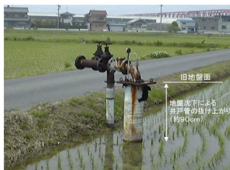
写真1 井戸の抜け上がり状況 5) (一部筆者が加筆)
